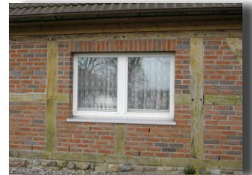
Abb.: fehlerhafter Einbau eines Fensters in eine Fachwerkkonstruktion
